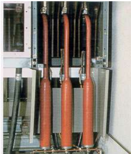
Αλεξικέραυνα εσωτερικού χώρου μεταλλικού οξειδίου συνθετικού περιβλήματος
