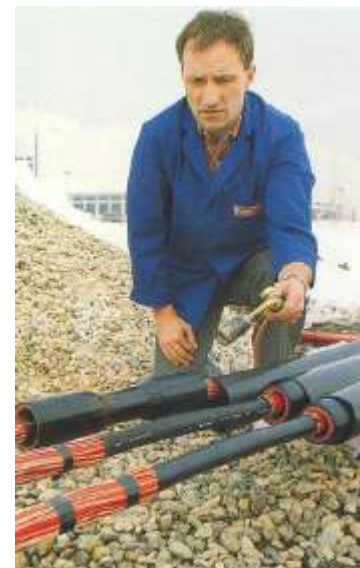
Ακροκιβώτια ενισχυμένου τύπου για ορυχεία
